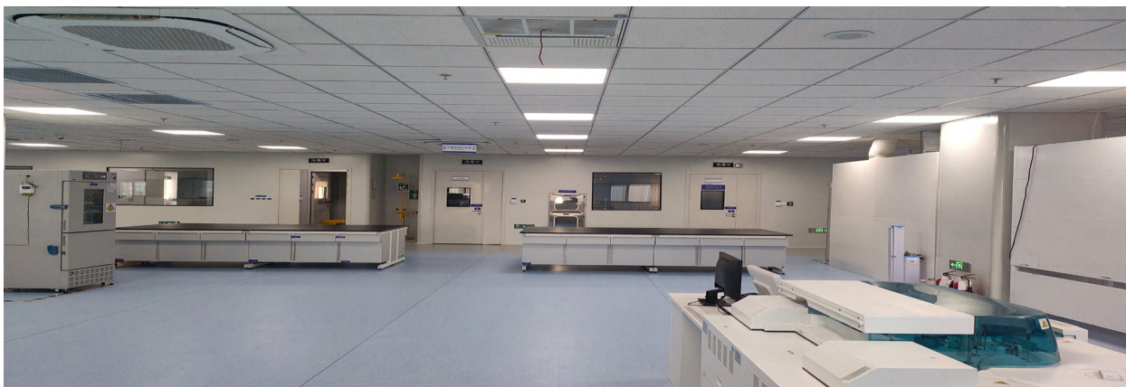
全面採用 LED 燈具與變頻設備的實驗室
